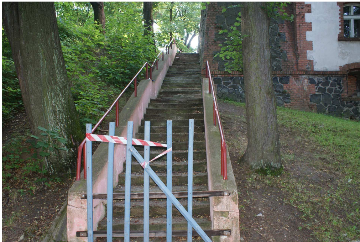
bieg schodowy - widok z dołu
