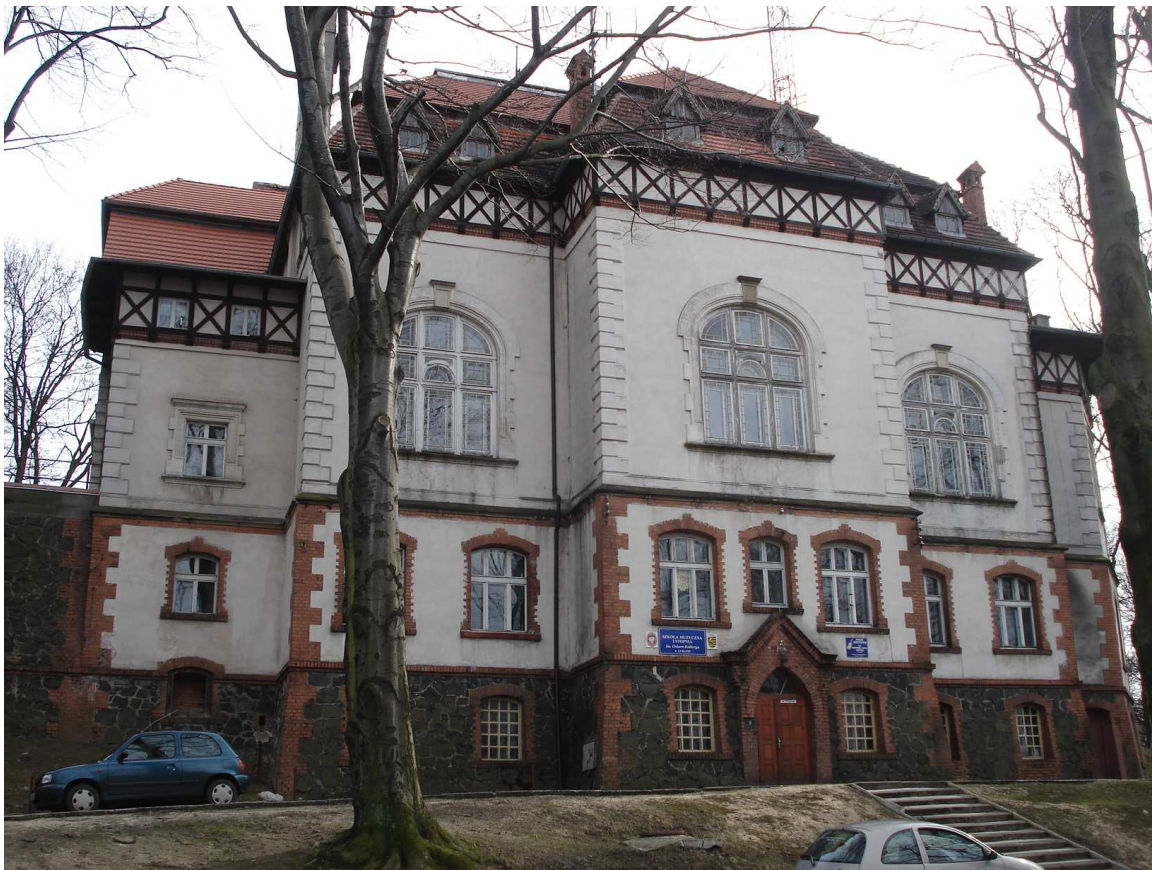
budynek Szkoły Muzycznej - elewacja frontowa
